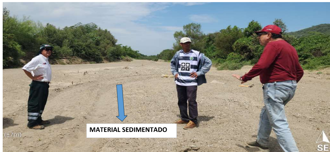
Figura N° 02: Se observa la colmatación en el cauce del río Piura en el Sector Pabur
